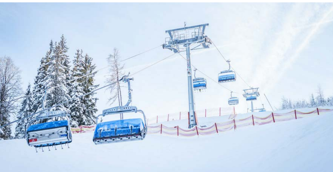
Der neue Wasserkarlift bringt eine neue, anspruchsvolle Piste am Gaislachkogel.
